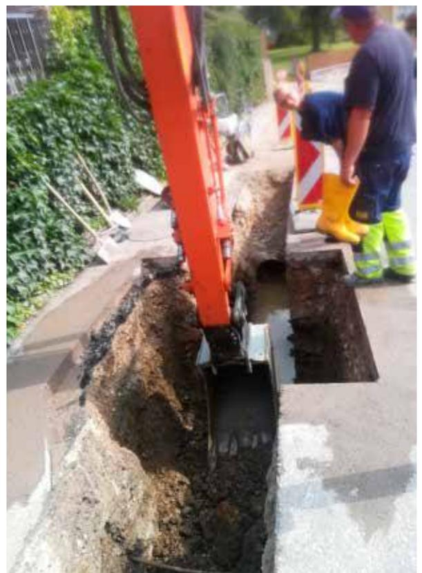
Wie Ihnen sicher nicht entgangen ist, ist die Sanierung des Oberflächenwasserkanals seit einigen Wochen in vollem Gange. Dessen desolater Zustand war uns aus den Vorprüfungen bekannt – während der Arbeiten wurden sämtliche Schäden ersichtlich und die Notwendigkeit der Reparatur hat sich bestätigt.
