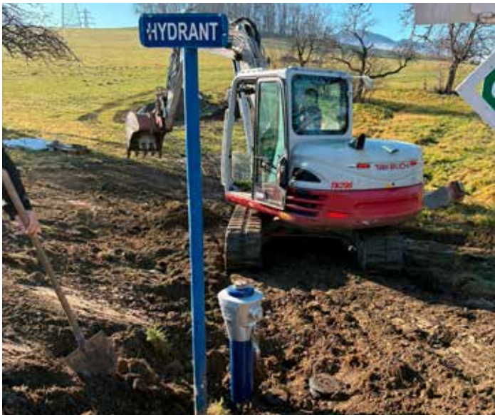
Reparatur eines defekten Hydranten in Schönstabl
